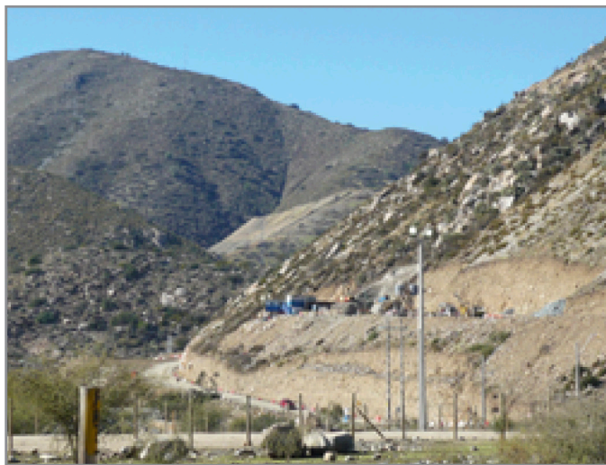
Эрозия вдоль подъездной дороги, рудник Пеламбрес, Чили. Фото: Росио Авила Фернандес
