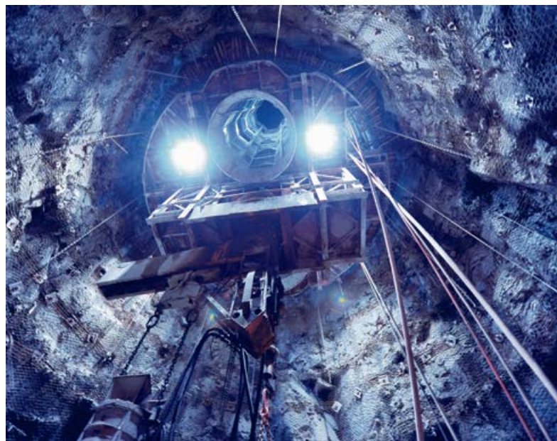
Проходка ствола на новой шахте Стилдрифт фирмы Ройал Бафокен Платинум
